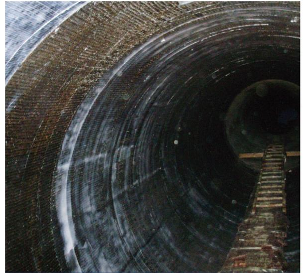
Reforzamiento con Tyfo® en tubería de agua
